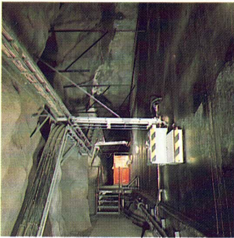
1. Gång mellan bergrumsvägg och huvudbyggnad. I bakgrunden vågfälla för ingången.
